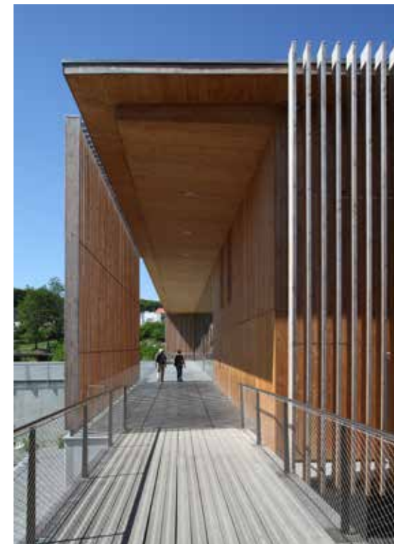
L'habillage bois de la partie supérieure
