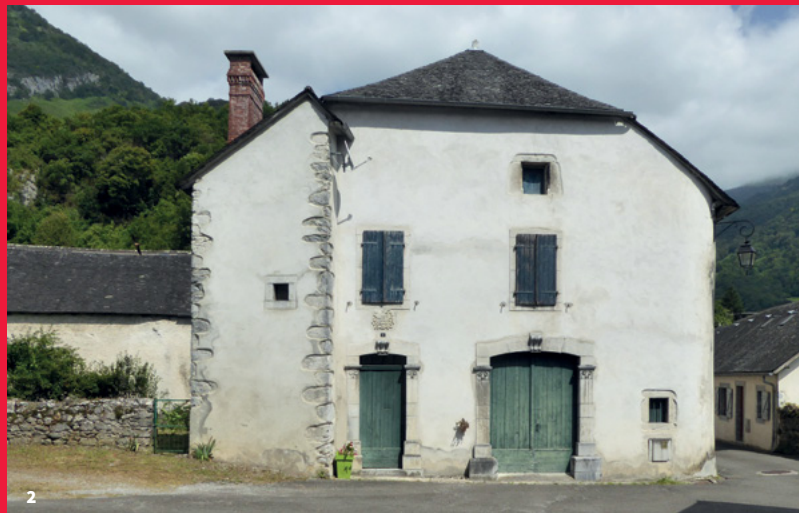
1. Aydius, exemple d'adaptation à la pente de la maison bloc : grange, logis et grenier disposent chacun d'un accès direct sur l'extérieur
