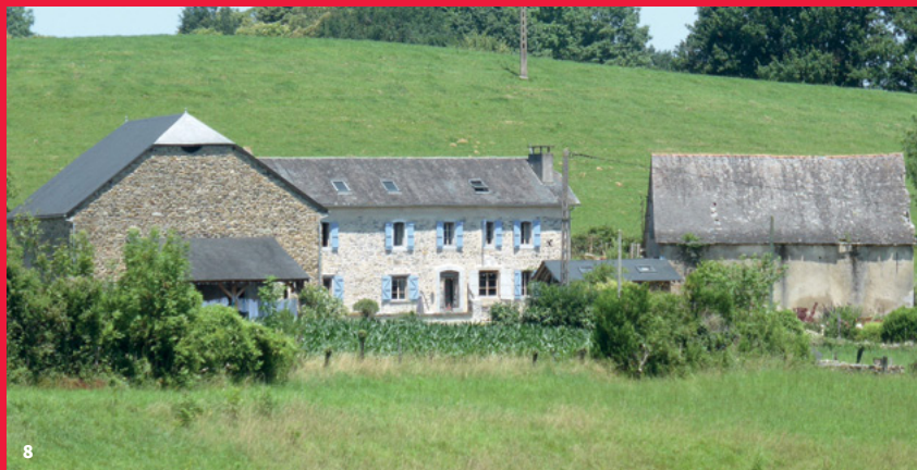
7. Ogeu-les-Bains, grande maison à cour classique de village, marquée par le gabarit imposant du bâti en équerre et la taille de la cour desservant deux granges
